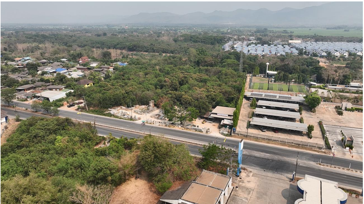
รูปที่ 5-16 ช่วง กม.12+650 จุดตัด ทล.1035 (แนวถนนสายแยก ทล.11 ถึง ทล.1 อ.เมือง จ.ลำปาง ตอนที่ 2)
