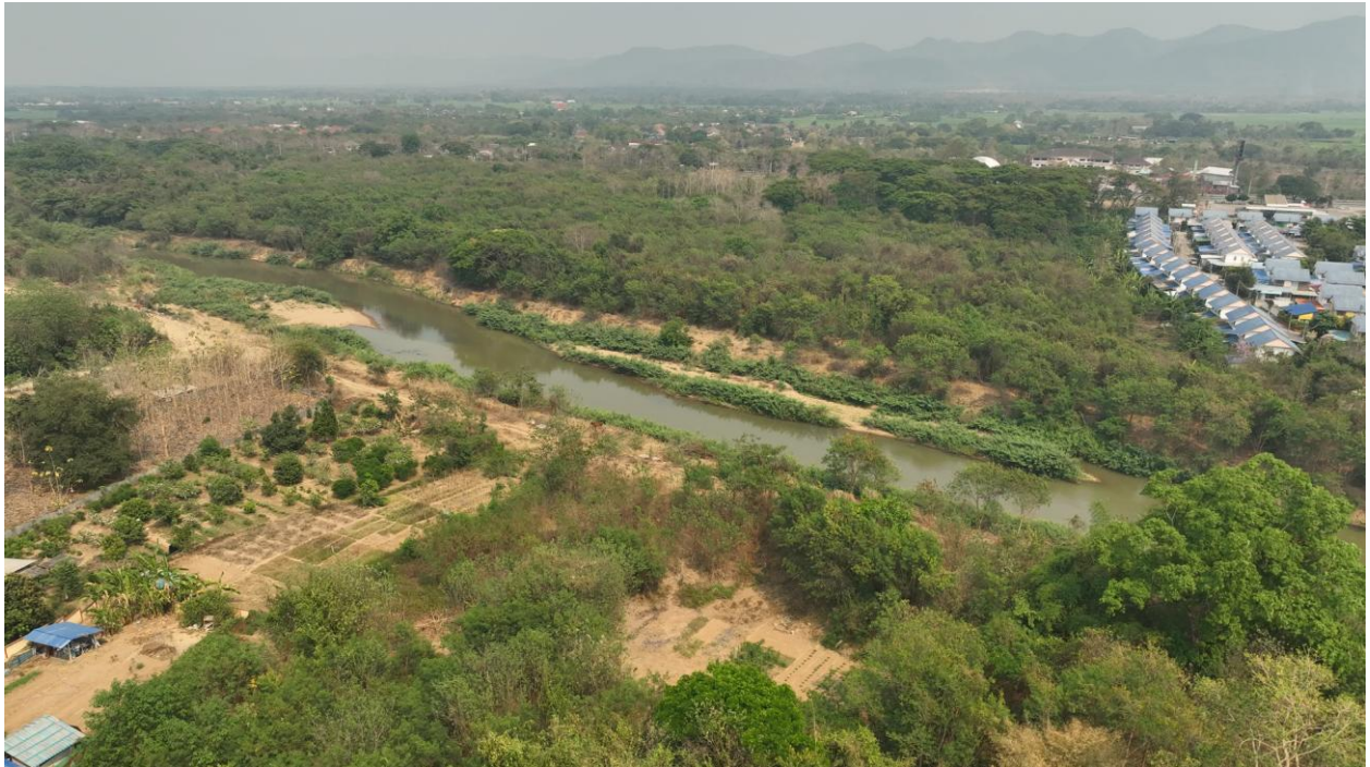
รูปที่ 5-17 ช่วง กม.13+000 ผ่านพื้นที่เกษตรกรรมและตัดผ่านแม่น้ำวัง (แนวถนนสายแยก ทล.11 ถึง ทล.1 อ.เมือง จ.ลำปาง ตอนที่ 2)
