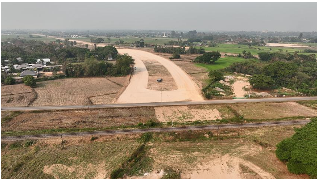
รูปที่ 5-2 ช่วง กม.0+700 ช่วงตัดเขตทางรถไฟ (พื้นที่ก่อสร้างถนนสายแยก ทล.11 ถึง ทล.1 อ.เมือง จ.ลำปาง ตอนที่ 1 อยู่ระหว่างดำเนินการก่อสร้าง)
