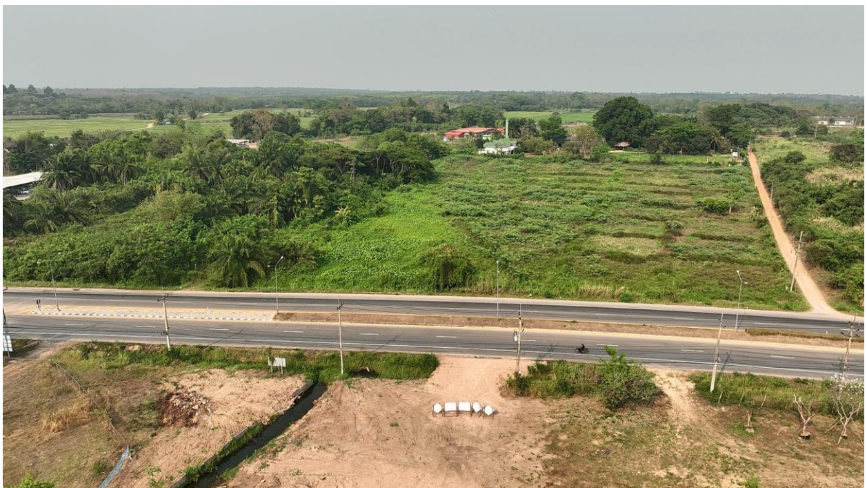
รูปที่ 5-8 ช่วง กม.5+300 ช่วงจุดตัด ทล.1157 (พื้นที่ก่อสร้างถนนสายแยก ทล.11 ถึง ทล.1 อ.เมือง จ.ลำปาง ตอนที่ 1 อยู่ระหว่างดำเนินการก่อสร้าง)
