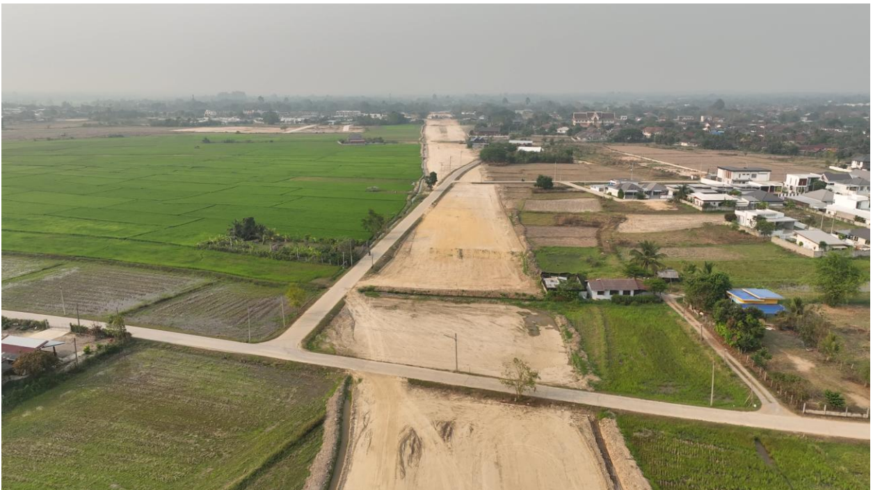
รูปที่ 5-4 ช่วง กม.2+000 (พื้นที่ก่อสร้างถนนสายแยก ทล.11 ถึง ทล.1 อ.เมือง จ.ลำปาง ตอนที่ 1 อยู่ระหว่างดำเนินการก่อสร้าง)
